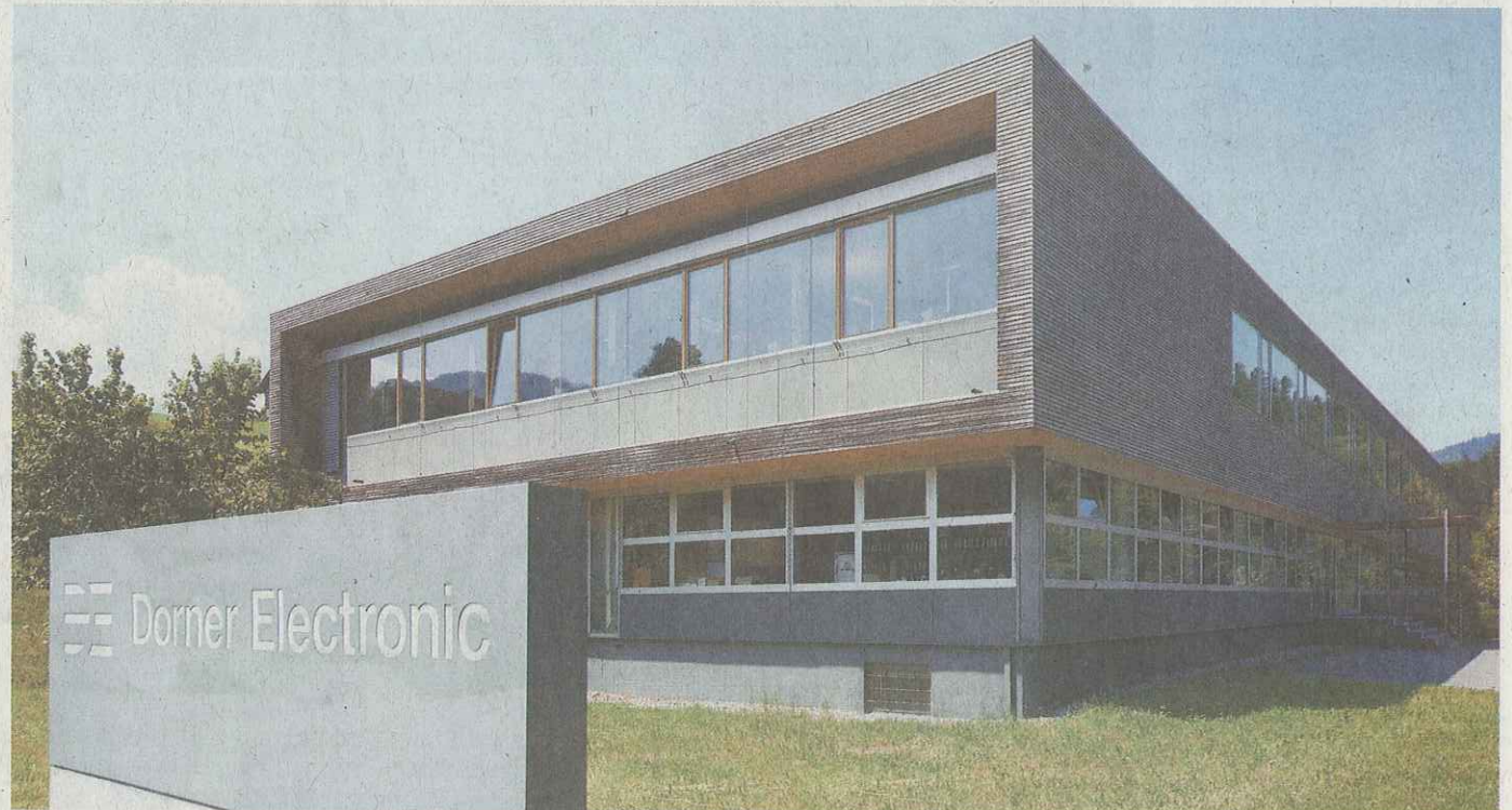
Auch als es um die Neugestaltung der Büros und Arbeitsplätze im Firmengebäude ging, wurde die Meinung der Mitarbeiter eingeholt.
